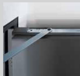
Türschließer nur von innen sichtbar
