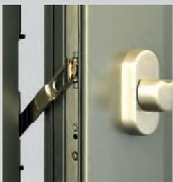
Sperrbügelschloss mit Drehknopf
